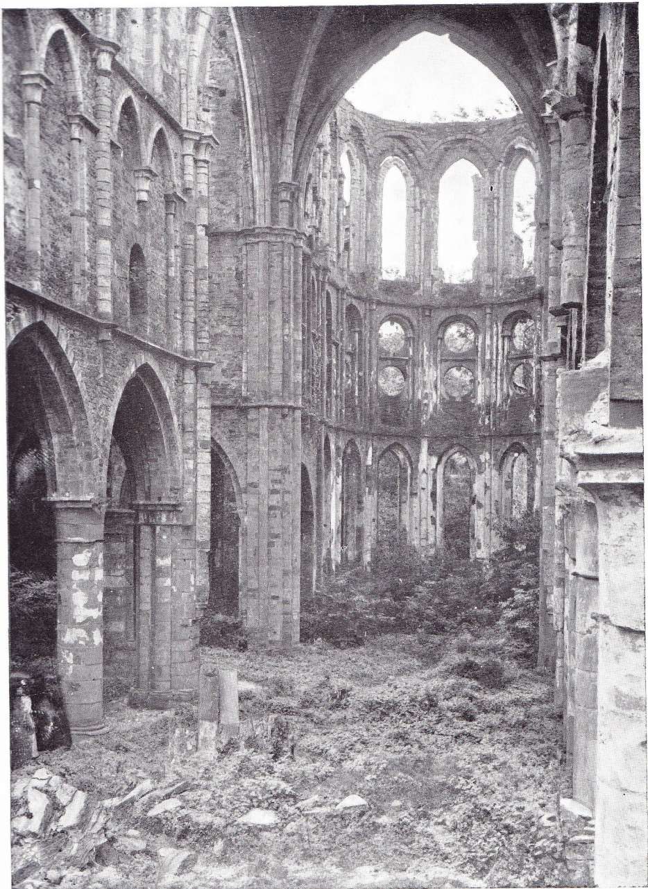
42. — ABBAYE DE VILLERS. Vue du chœur de l'église.
